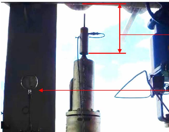
\* deve haver espaço suficiente ( mínimo 40 cm ) entre a ponta da haste da válvula e uma possível tubulação ou estrutura acima dela , para permitir a montagem do TEVSA .
